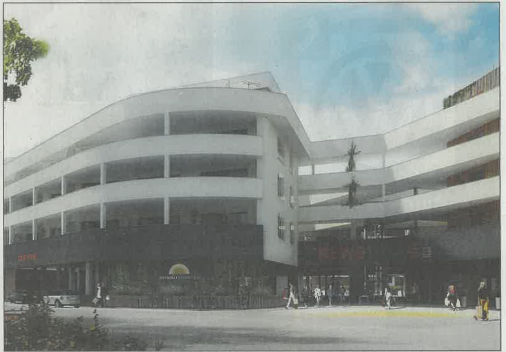
• Auf dem neuen REWE-Markt werden vier Wohnhäuser terrassenförmig angelegt.
